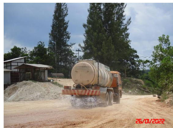
รูปที่ 2-22 การฉีดพรมน้ำบริเวณพื้นที่โครงการ
