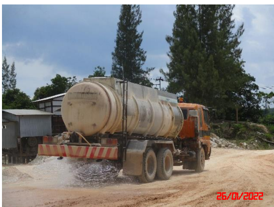
รูปที่ 2-22 การฉีดพรมน้ำบริเวณพื้นที่โครงการ
